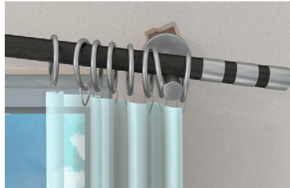
Reparatur ausgerissener Bohrlöcher
