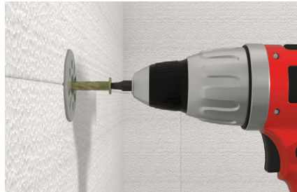
Geschraubte Befestigung von Dämmstoffplatten
