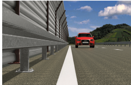
Leitschranken und Lärmschutzwände
