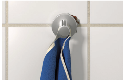
Reparatur ausgerissener Bohrlöcher
