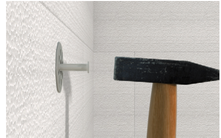
Geschlagener Dübel auf Polystyrol-Hartschaumplatte
