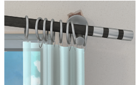
Reparatur ausgerissener Bohrlöcher
