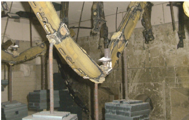
Vor der Brandprüfung
